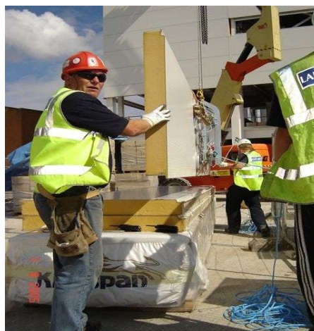
Horizontale Verlegung an der Wand
