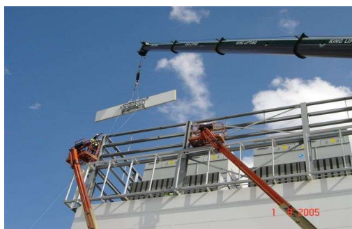
Vertikale Montage, Octopus am Kranhaken.
