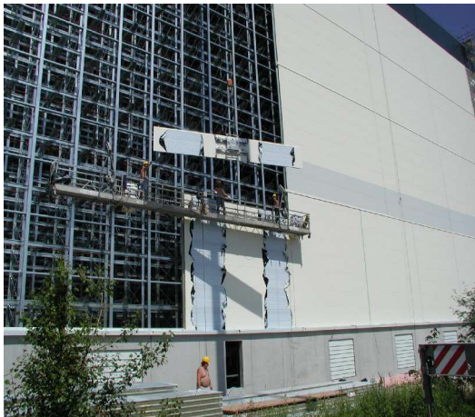
Horizontale Verlegung an der Wand
